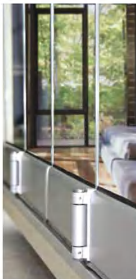
Στεγανοποιητική βούρτσα ανάμεσα στο κάτω προφίλ και το δάπεδο / Weather proofing brush between bottom profile and the floor
